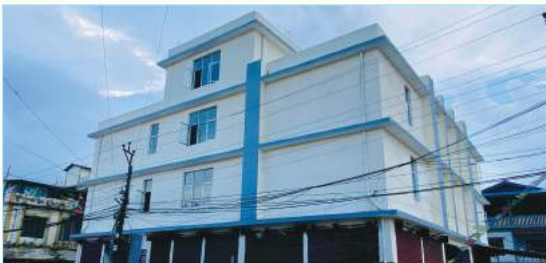
बिर्तामोड नगरपालिका-३ बिर्ताबजारमा निर्माण सम्पन्न भएको कृषि कम्प्लेक्स ।
