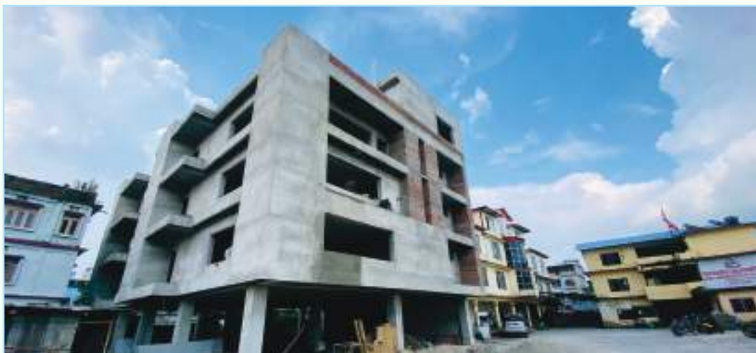
बिर्तामोड नगरपालिकाको निर्माणाधीन प्रशासनिक भवन ।
