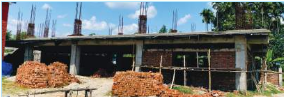
बिर्तामोड नगर अस्पतालको निर्माणाधीन नयाँ भवन ।
